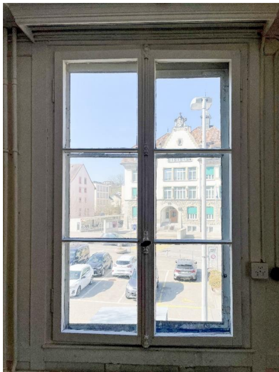
Anschlag Fenster Obergeschoss. Links Rahmen fast bündig. Rechts Anschlagdetail auf Holzfutter.
