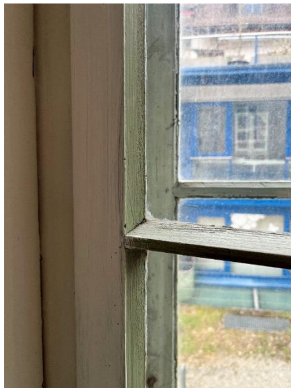
Links: Detail mit Flügelwetterschenkel und profilierter Schlagleiste. Mitte Flügelprofil und Sprossenprofil mit zierlichem Fas. Rechts Wolfsrachen.
