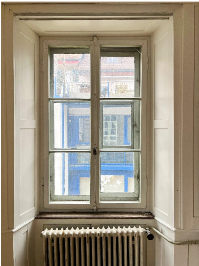
Fenster links ohne Lüftungsflügel.
