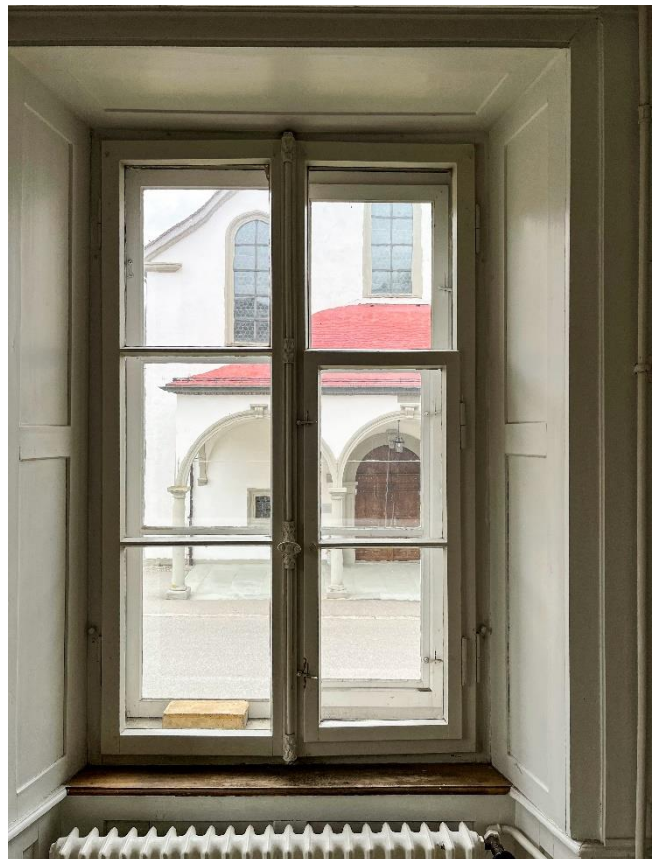
Rechts mit Lüftungsflügel.
