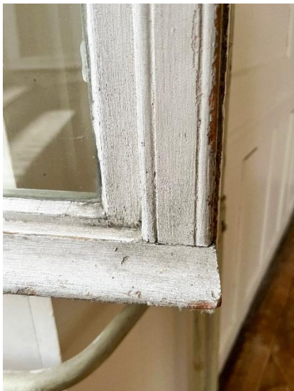
Links: Detail mit Flügelwetterschenkel und profilierter Schlagleiste. Mitte Flügelprofil und Sprossenprofil mit zierlichem Fas. Rechts Wolfsrachen.
