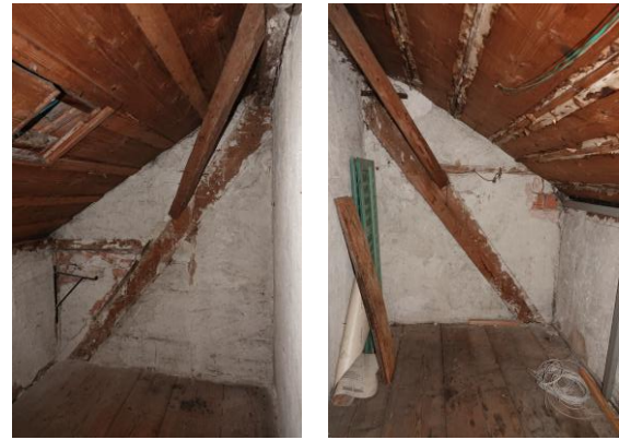
Stuhlstreben mit angefügten Windstreben im Schlupf SW
