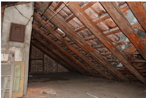
Sparrendach im Kiehlbalkengeschoss gegen Süden
