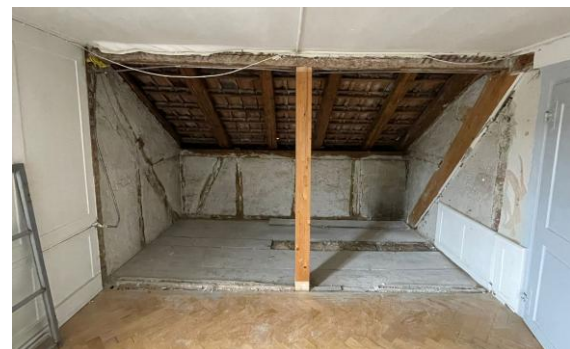
Kniestockwand Nordwest, anstelle der Windstreben steht ein sekundärer Ständer. (Foto SW)
