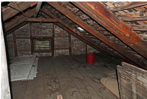
Sparrendach im Kiehlbalkengeschoss gegen Osten
