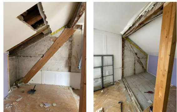
Untermauerte Stuhlbinden Mitte-Nord und West Die Windstreben und die Untermauerung vom Stuhlrähm fehlen. (Fotos SW)
