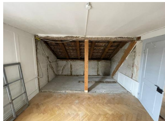
Untermauerte Stuhlbinden Mitte-Nord und West Die Windstreben und die Untermauerung vom Stuhlrähm fehlen. (Fotos SW)
