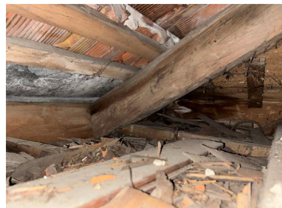
Dachfuss Nordost mit Senkelschnitt des Sparren
